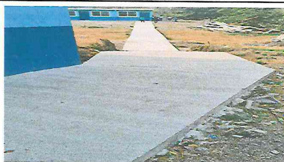
LOSA DE PATIO terminado el trabajo de fundición de losa quedo en buenas condiciones que es de mucho beneficio de los alumnos.
