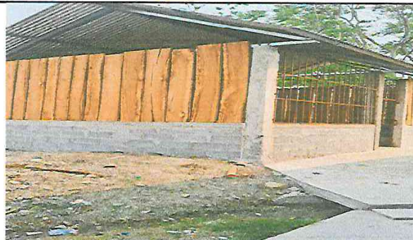
COCINA: Así quedo el trabajo de la construcción de cocina del establecimiento que será de mucho uso en la preparación de alimentación escolar.
