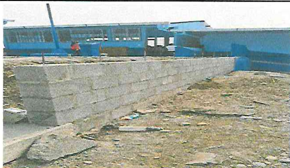
MURO DE CONTENCIÓN: finalización de trabajo en la construcción de muro de contención del predio del establecimiento.
