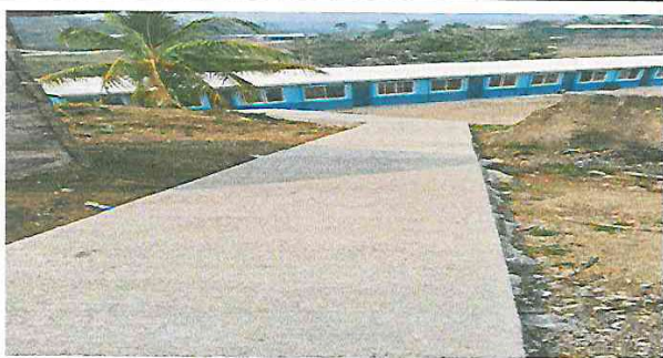
GRADAS quedo excelente el trabajo de fundición de losa y grada.
